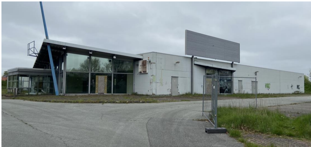
Abbildung 45: Blick auf die leerstehende Sky-Immobilie
